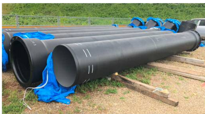
写真 基幹管路更新工事
