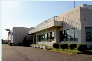
下般若配水場（外観）
