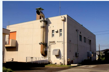
後飛保配水場（外観）
