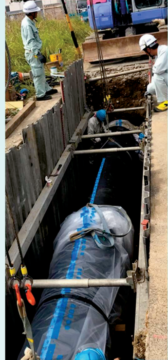
基幹管路更新工事
