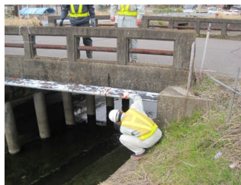
写真-3.4 目視点検状況
