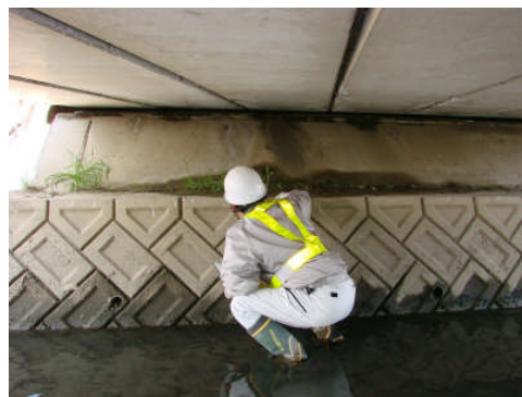
写真-3.2 専門業者による点検状況
