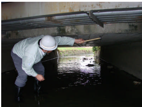
写真-3.1 職員による点検状況
