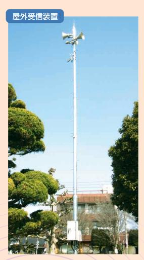
親局から無線回線で信号を受信し、 周辺住民に対し拡声放送を行うほか、 停電時には内蔵バッテリーにより一 定の間運用することができます。
